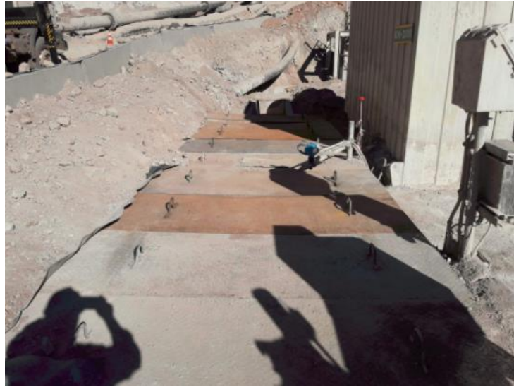
Figura 3-14: Fabricación e instalación de planchas sobre desarenador IPA2
