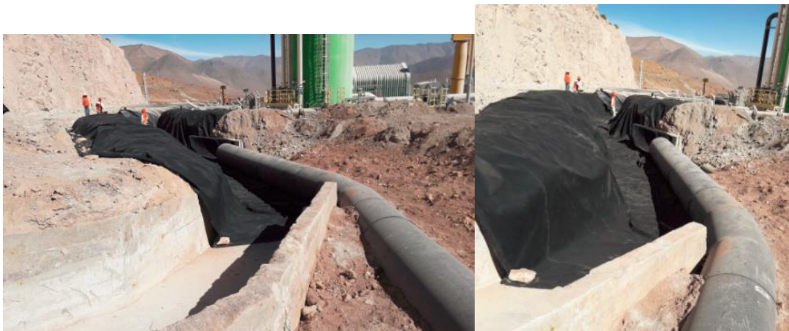
Figura 3-4: Avance impermeabilización zanja (12-04-2018)
