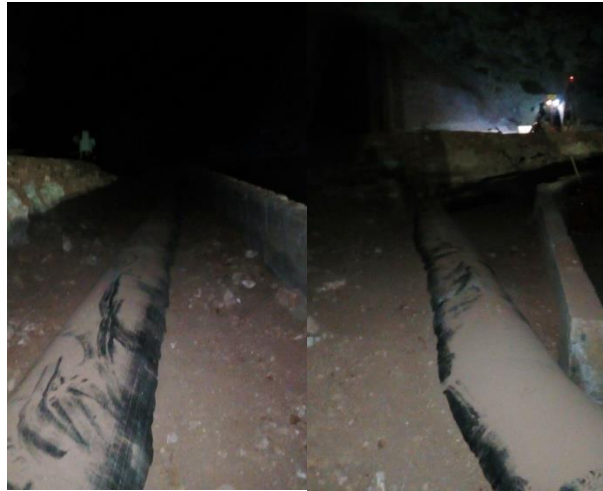
Figura 3-9: Tapado en media caña a línea de 800 mm (09-04-2018)
