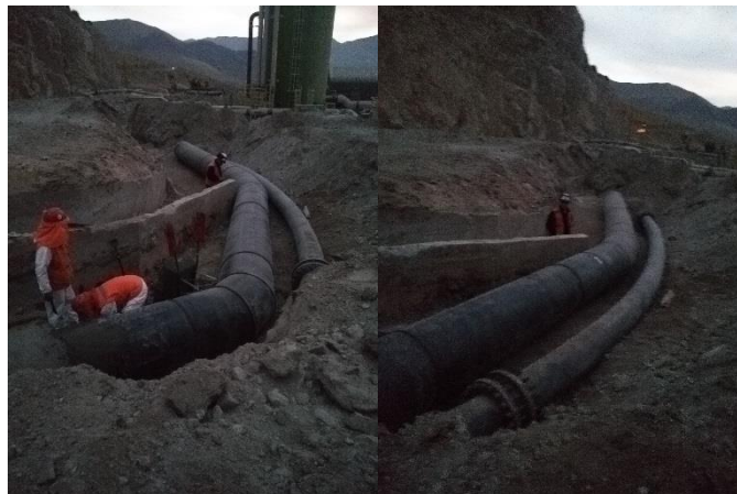
Figura 3-7: Se instala codo en tubería de 800 mm, se finaliza extensión de línea para empalmar en canalón costado booster 2 (09-04-2018)
