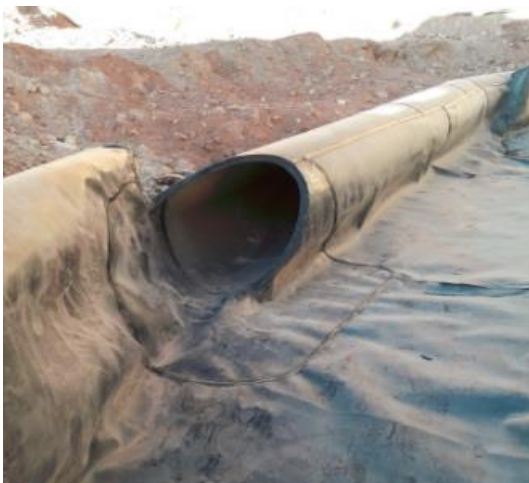
Figura 3-11: Impermeabilización de descarga al Canal
