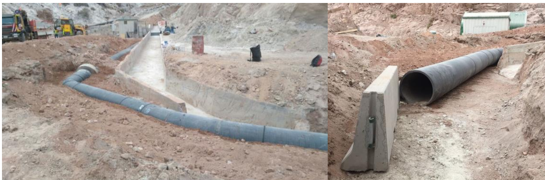
Figura 3-10: Relleno zanja de tubería 800 mm (10-04-2018)
