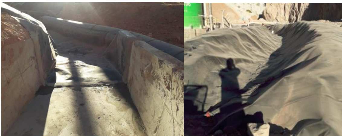
Figura 3-5: Impermeabilización zanja continuación canal de hormigón costado IPA2 (13-04-2018)
