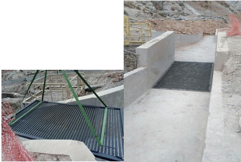
Figura 3-2: Instalación Parrilla en sumidero (10-04-2018)
