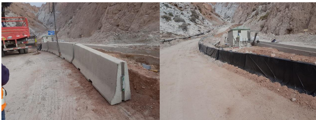
Figura 3-16: Instalación de new jersey (10-04-2018)
